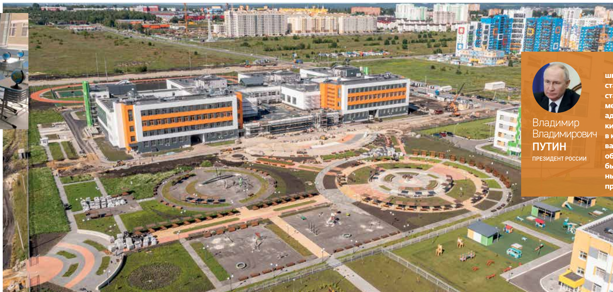
Строительство МБОУ СОШ № 1 им. Л. Б. Ермина, с. Засечное, Пензенская область
