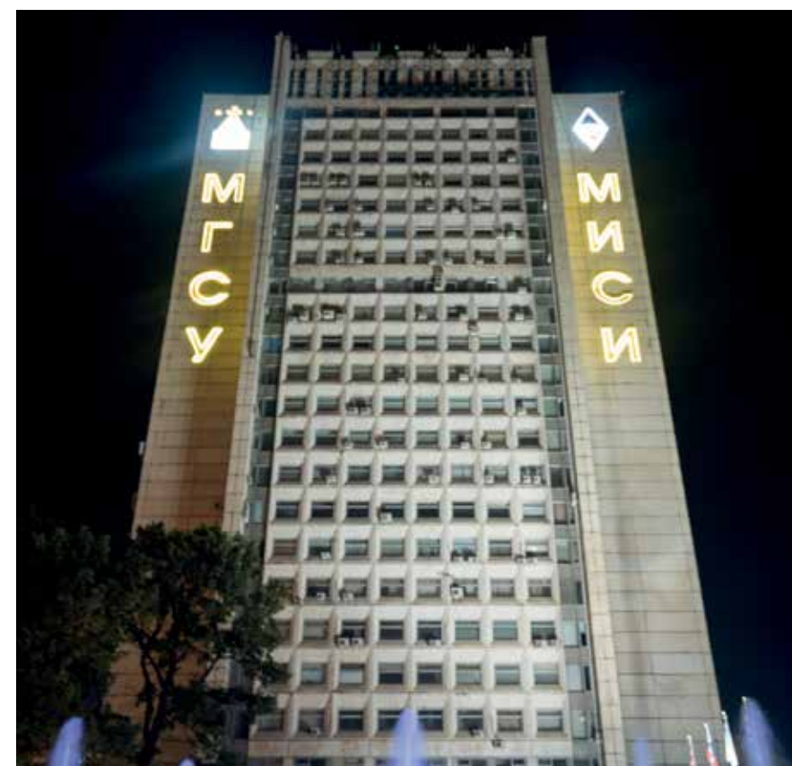
Общий вид НИУ МГСУ, г. Москва
