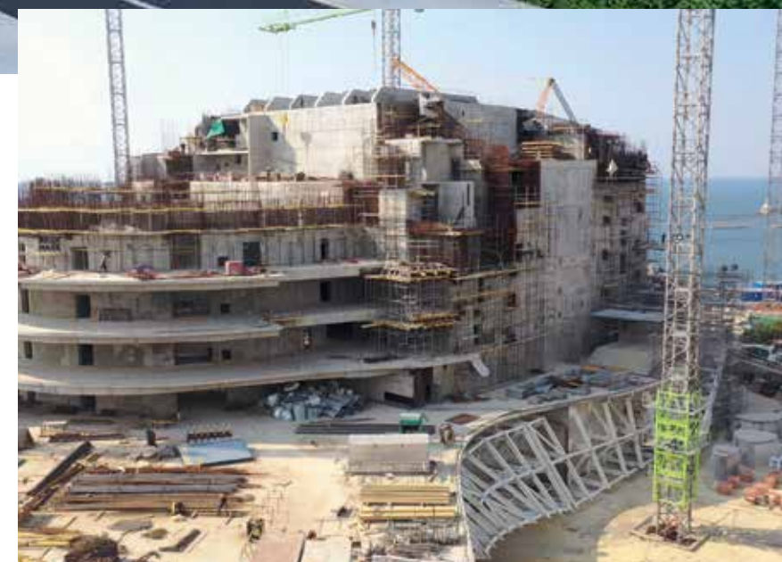
Строительство театра оперы и балета в г. Севастополе
